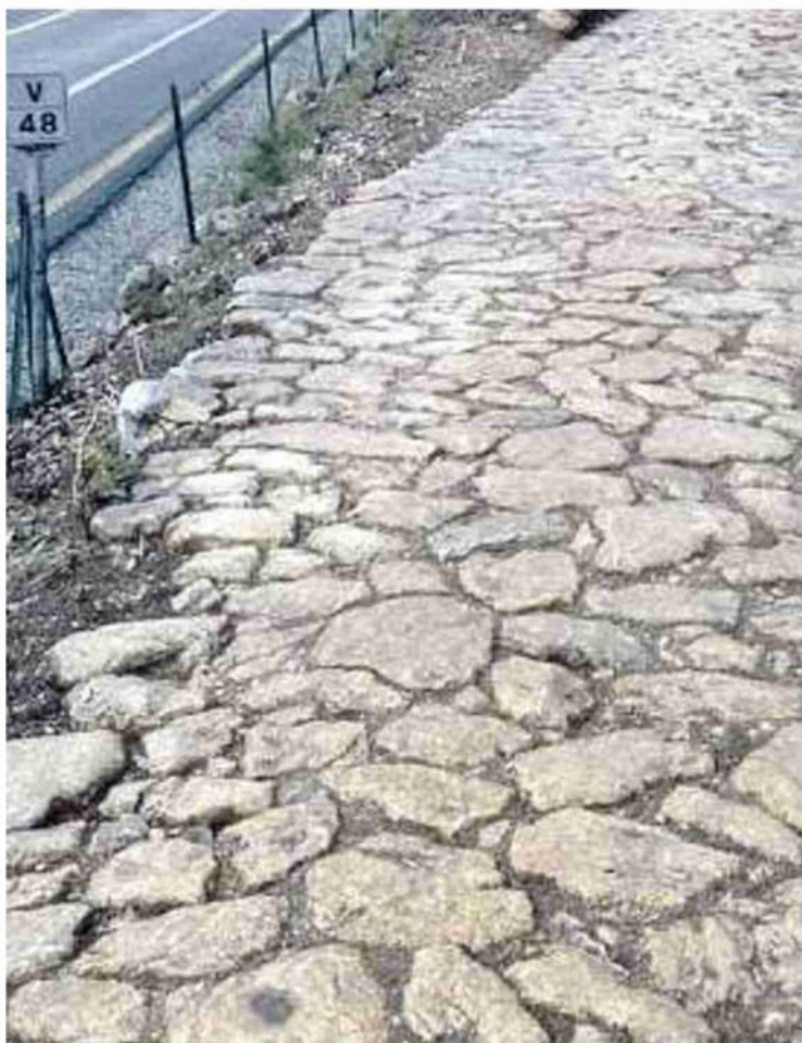
Un tratto del tracciato di epoca romana riemerso durante i lavori per l'ampliamento della Salaria (foto da FACEBOOK)
