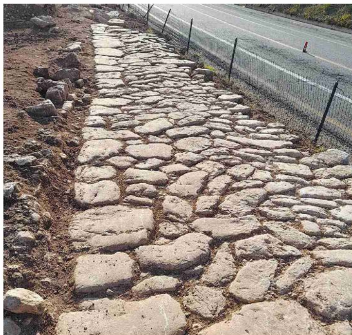
Via Salaria Il lastricato in pietra rinvenuto durante i lavori di sbancamento
